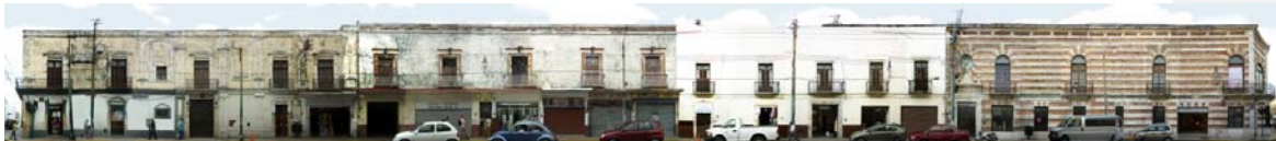
FIGURA 2. Paramento estado actual
