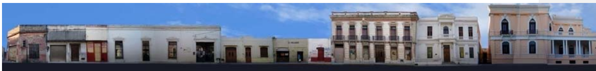
FIGURA 2. Paramento estado actual
